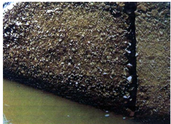
Hình 2.1 Ăn mòn bê tông cống Vàm Đồn - Bến Tre
