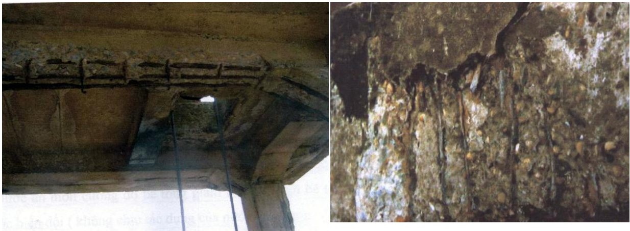
Hình 2.3 Ăn mòn cốt thép dần van cổng sau 22 năm - Nam Định
